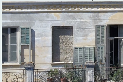
Apertura tamponata | Piano terra
