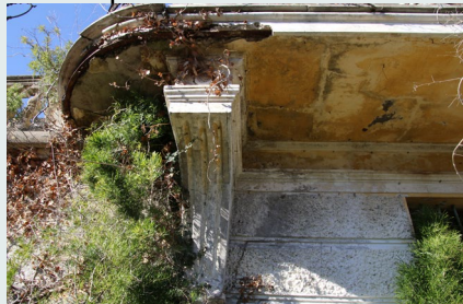
Mensola di sostegno | Particolare
